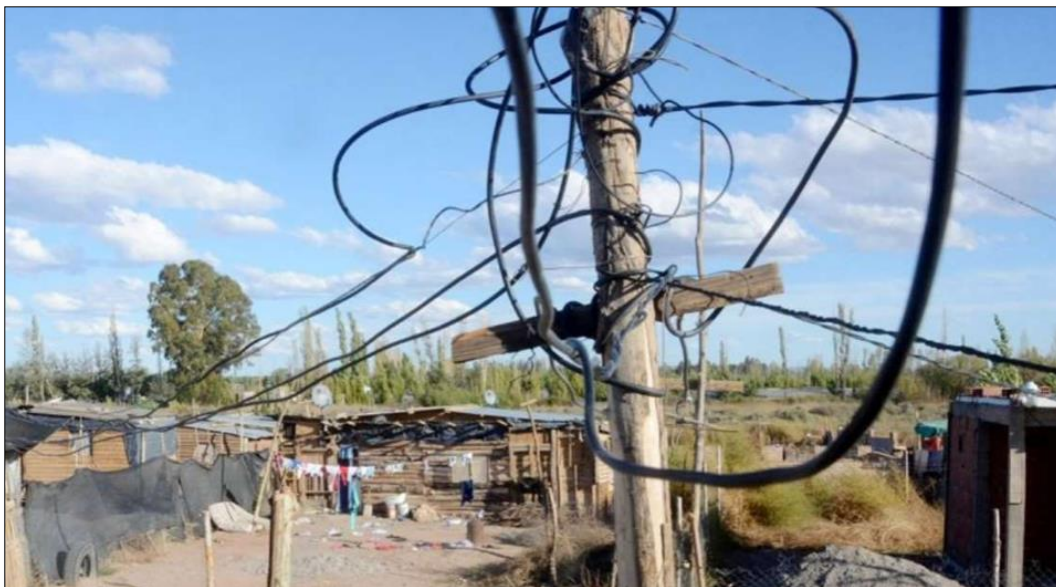
Imagen 5: Conexiones Eléctricas Seguras
