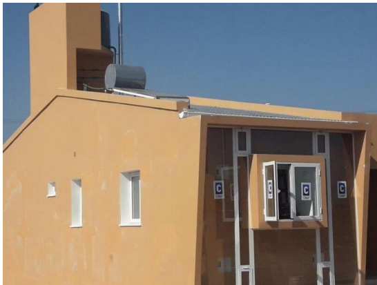
Figura 58. Termotanque solar de la vivienda sostenible
